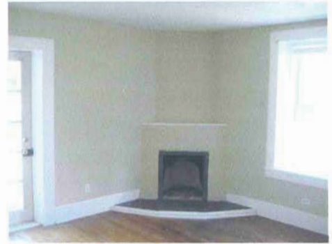
86 N.BEDROOM FIRE PLACE
