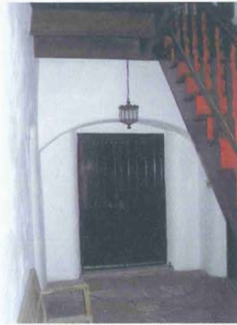
129 DOWNSTAIRS HALL S DOOR
